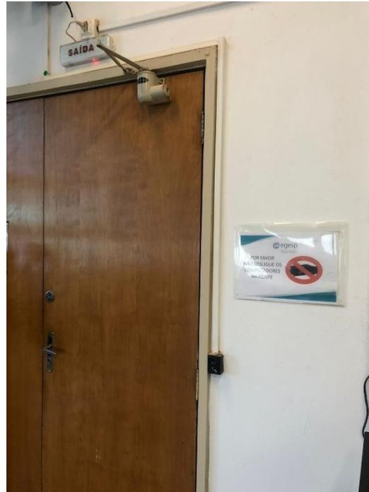
Situação atual: tomadas existentes, luminária sinalizadora de saída de emergência e acionamento do ventilador.
