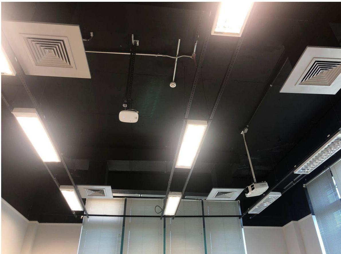
Situação atual: iluminação aparente, eletrocalhas, tubulação de ar-condicionado central, detector de fumaça e retroprojetores fixados na laje.
